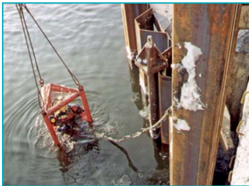
SPG Hydro International, port de Trois-Rivières
