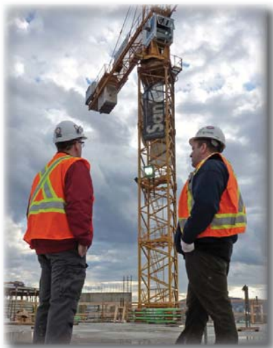
Luc Bertrand, conseiller en prévention, discutant avec Michel Lessard, agent de sécurité, sur le chantier Rosemont du maître d'œuvre Conception Habitat 2000.
